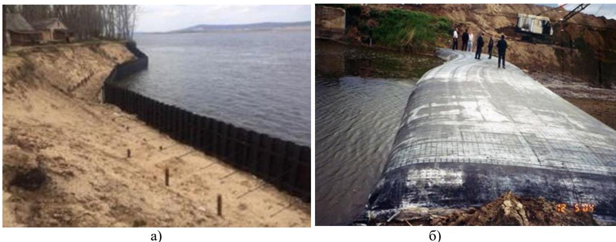
Рисунок 1 – Модульные защитные барьеры (а) и быстровозводимая гибкая дамба (б)
