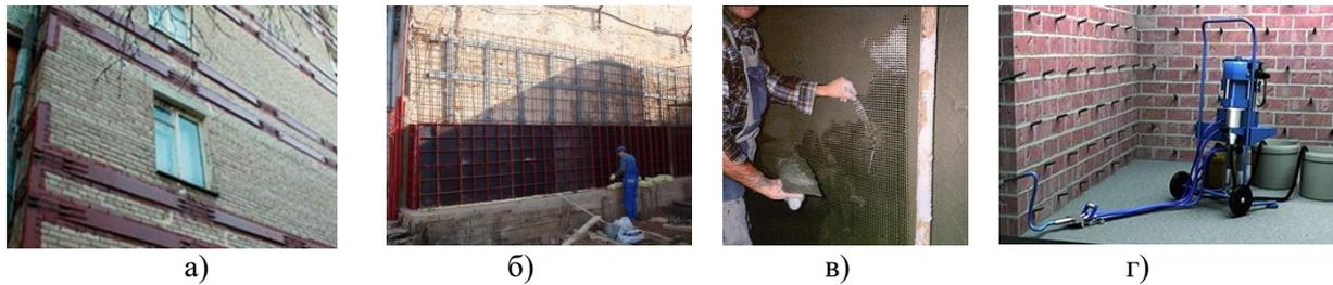
Рисунок 1 – Варианты усиления кирпичных стен а) металлической обшивкой, б) железобетонной обшивкой, в) штукатурка по углеродной сетке, г) методом инъектирования.
