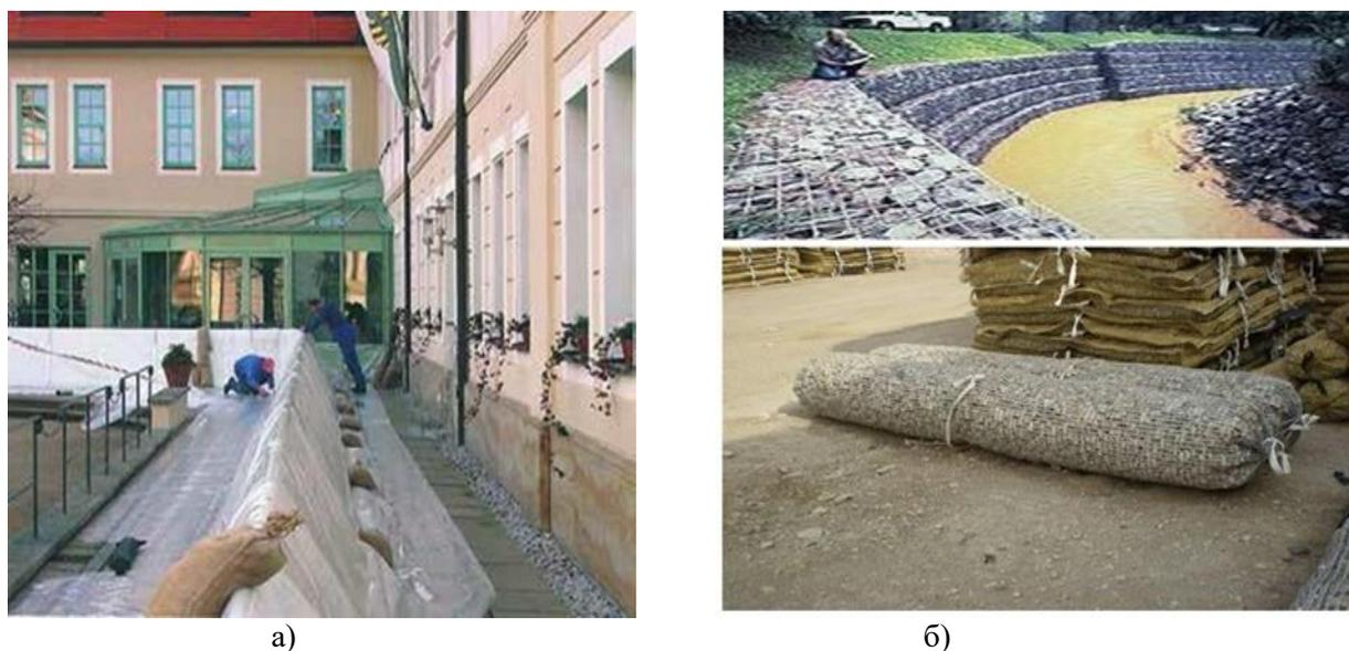
Рисунок 2 – Применение системы AquaStop (а); габионы (б)
